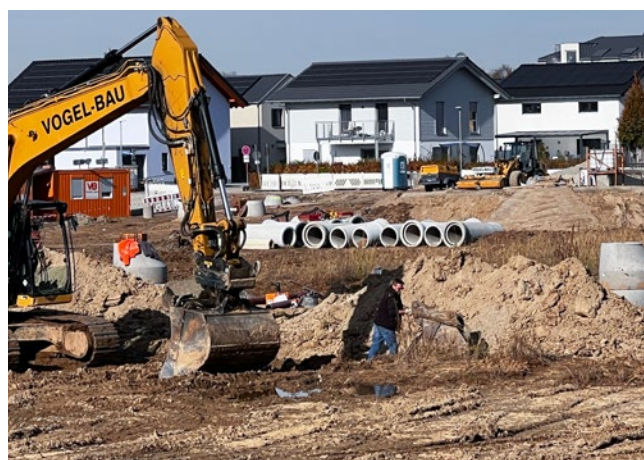
Erschließungsarbeiten im Baugebiet „Suppterten II“
